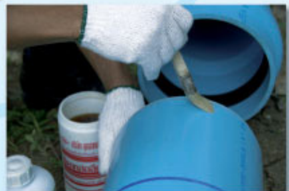
ทานํ้ายาหล่อลื่นบริเวณที่ลบบนคันท่อและผิวภายนอกท่อด้านปลายเรียบโดยรอบจนถึงบริเวณที่ทำเครื่องหมายไว้
